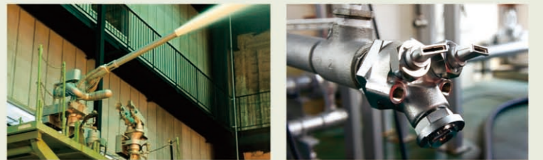
放水型ヘッド等を用いるスプリンクラー設備 Sprinkler systems using discharge-type heads
