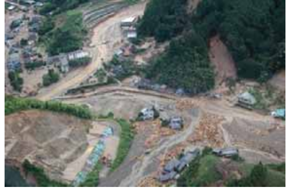
朝倉市松末地区の被害状況 (兵庫県消防防災航空隊提供)
