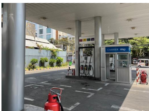
プノンペン市内の給油施設 … 整理整頓され大型消火器も設置
