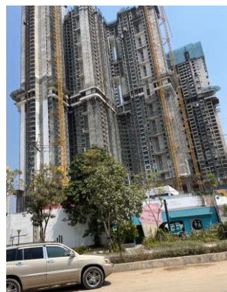
建設中の高層マンション群
