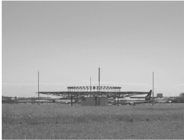
シドニー国際空港に設置されている VOR (112.1MHz の電波で運用されている)
