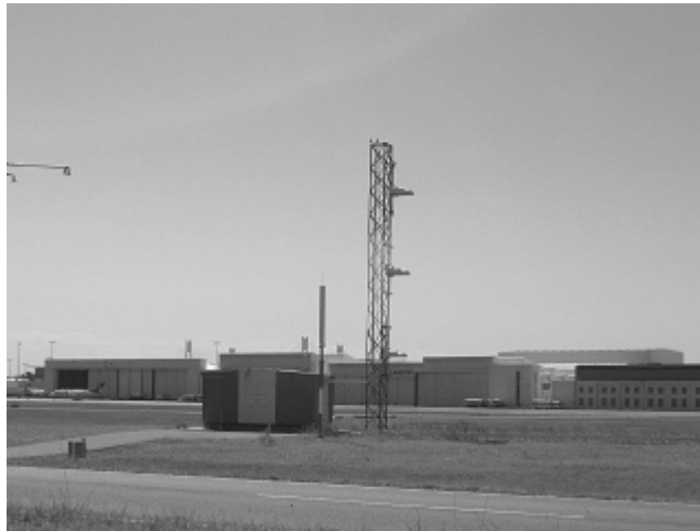
シドニー国際空港の滑走路 25 に設置されている ILS アンテナの一部 (109.7MHz の電波で運用されている)
