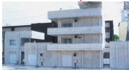
屋内火災防ぎょ訓練棟
